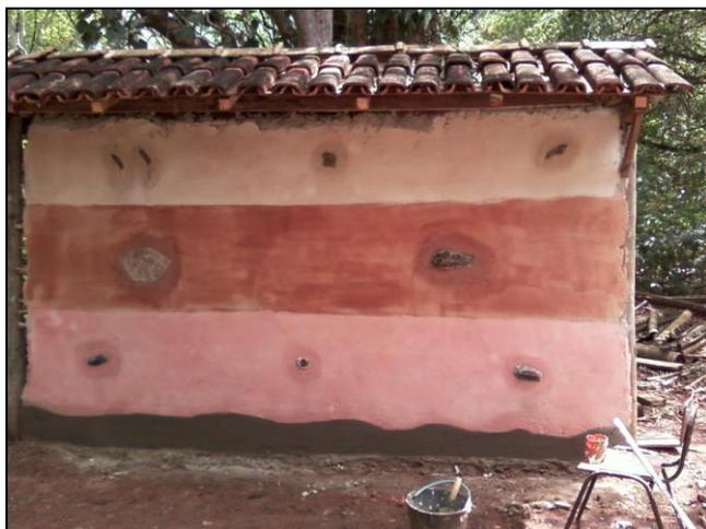
Figura 3. Parede de estratificação finalizada (bambu-a-pique)
